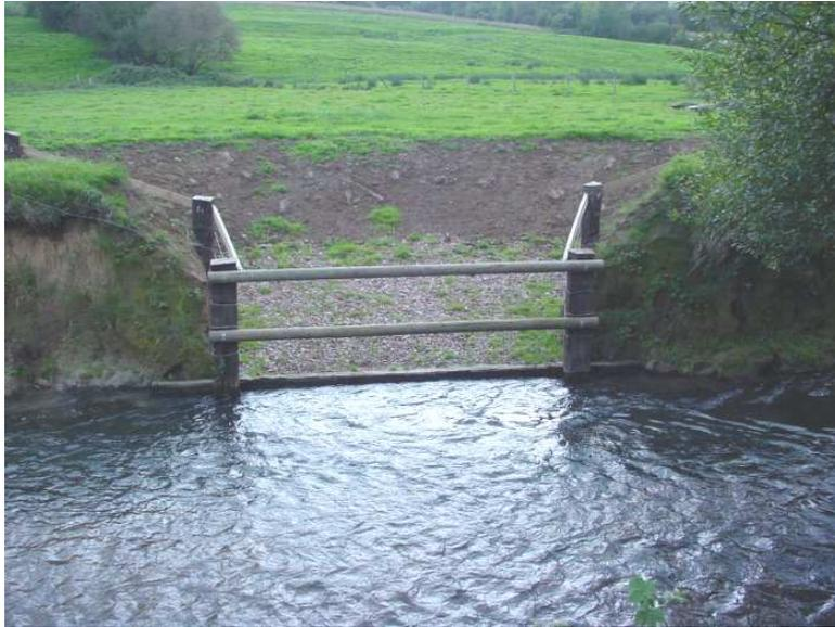
Les madriers ou diverses pièces de bois utilisés ne devront en aucun cas avoir fait l'objet de traitement chimique susceptible de dégrader la qualité de l'eau : trempages courts et longs, autoclave au cuivre-chrome-arsenic (autoclave au cuivre-chrome-bore autorisée). L'emploi de la traverse de chemin de fer est proscrite.
